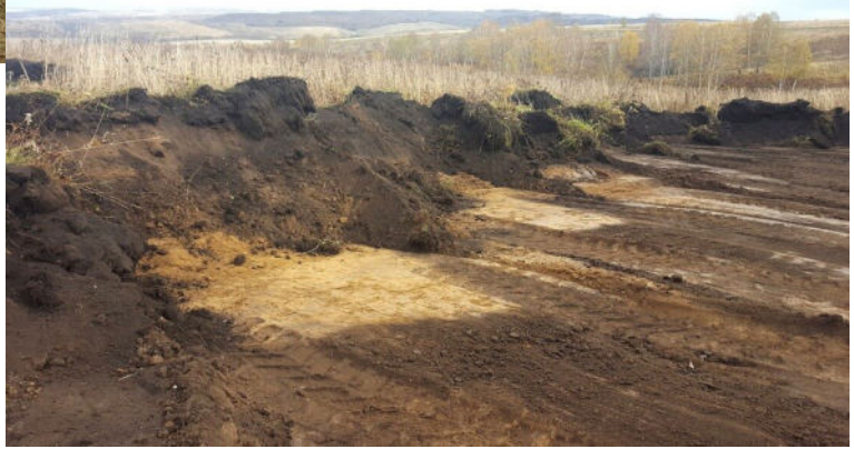
Рис. 2. Снятие жизнеспособного слоя почвы с эталонного участка, октябрь, 2018 г.
